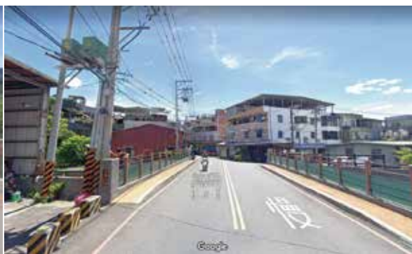
▲ 三龍街70號無名橋完工
