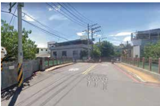
▲ 三龍街40號無名橋完工
