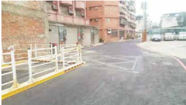
▲ 樹新路50巷拓寬工程完工
