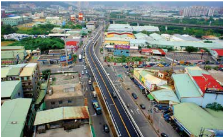
▲完工空拍照片
