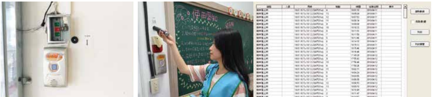
▲ 各出入口設置電子巡邏點
