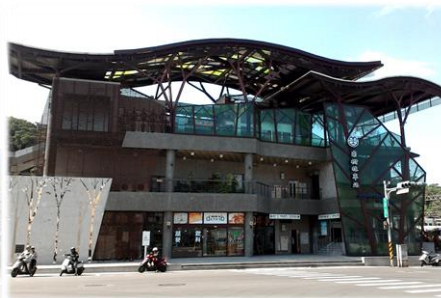
圖五 台鐵南樹林車站
