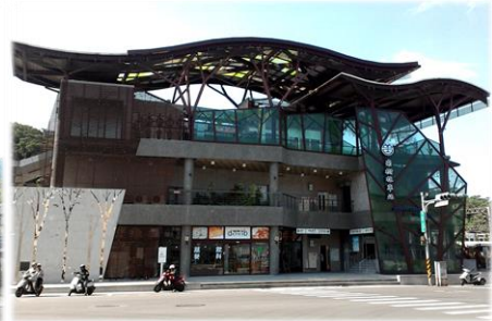
圖五 台鐵南樹林車站
